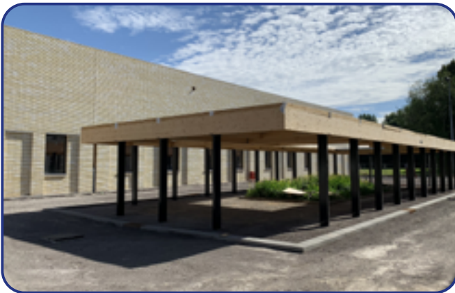
Construction d'une nouvelle école primaire à l'Athénée royal de Gosselies ©WBE
