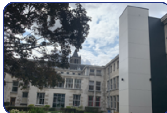
Nouvel ascenseur installé à l'Athénée royal Robert Campin ©WBE
